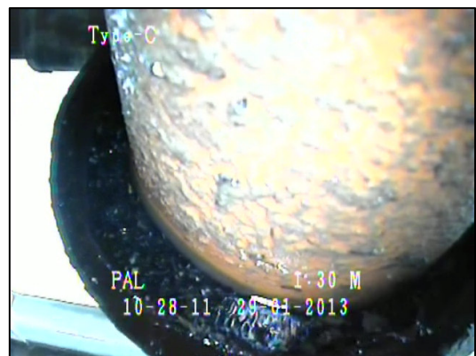
Foto 7-8-9: collettore di adduzione orizzontale e presenza di acqua all'interno del raccordo in ferro.
