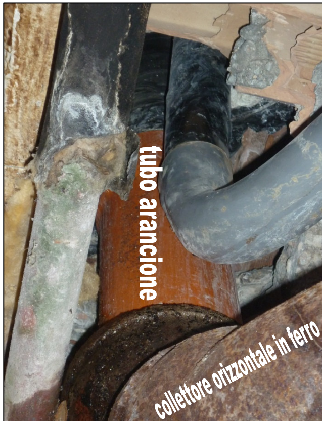
Foto 7-8-9: collettore di adduzione orizzontale e presenza di acqua all'interno del raccordo in ferro.
